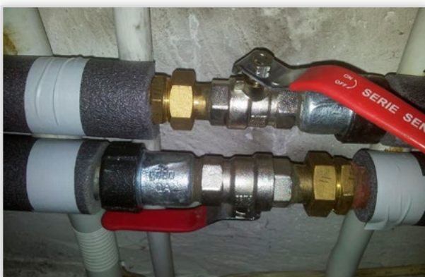
Przykład montażu złączek Gebo Quick z gwintem zewnętrznym na instalacji stalowej
